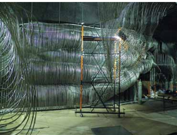
Монтаж конструкции инсталляции
